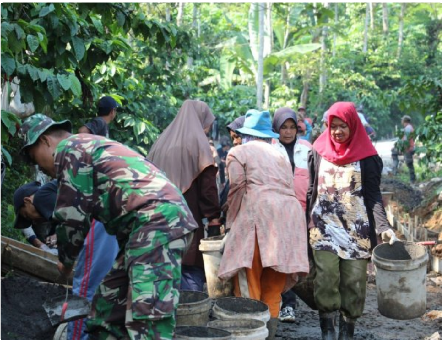
Ibu Ibu Bantu Percepat Pembangunan TMMD
